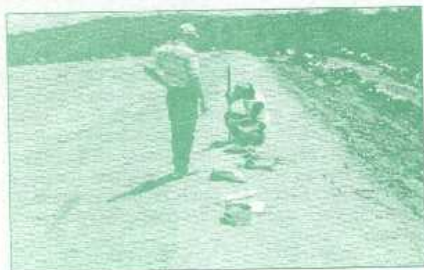
Fig. 2. Pruebas finales para garantizar un nivel de compactación del 90% en bordos.
