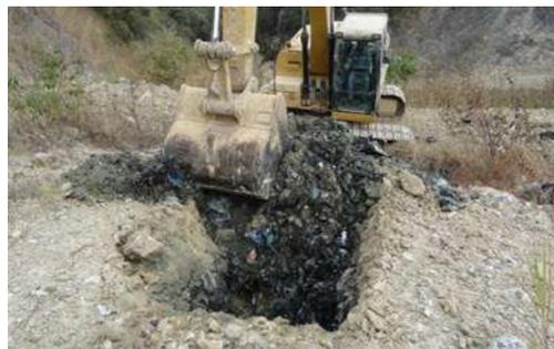
**Figura 4.** Obtención de la muestra de Residuos estabilizados
