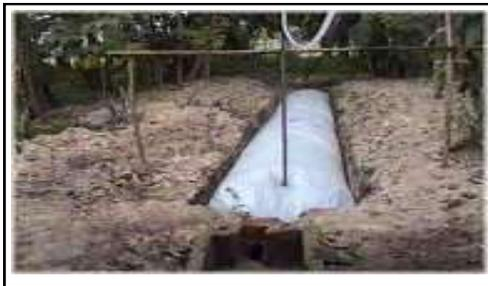
**FIG 4:** Biodigestores de estructura flexible
